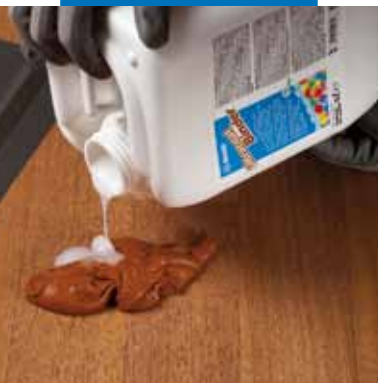
Mischen von Merbau Schleifstaub mit Ultracoat Binder
