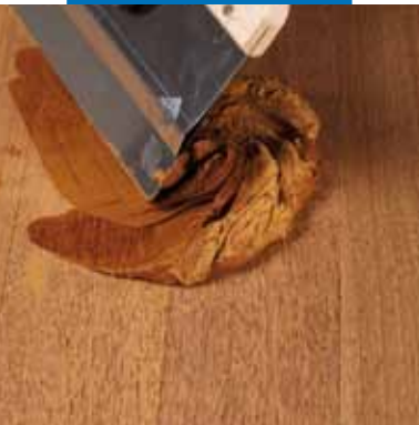
Mischen von Ultracoat Binder
